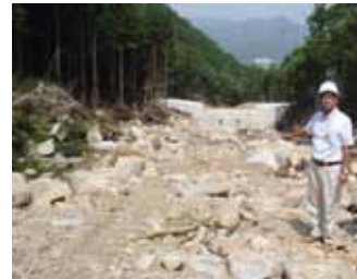
防府市の土石流災害現場にて
