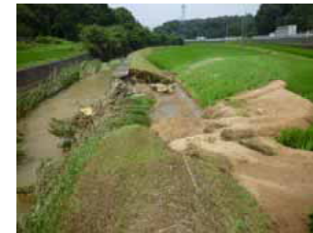
上：資料を手に質問する (2009.6.18) 中：「広谷タメ池」(小野区小野) (2009.7.24) 下：護岸の崩壊(二俣瀬区割木松) (2009.7.24) 右上：防府市の土石流発生現場にて 2010.7.5
