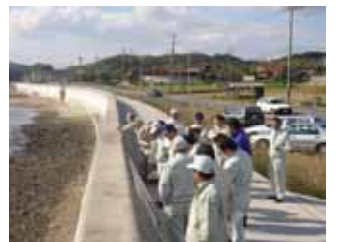
防波堤のかさ上げ工事の現場視察
