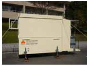
(h) 連続的に設置した場合のプライバシー確保のため、片面には窓が設置されていない
