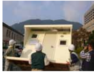
(e) 最後に前面の壁を起こす。ボックス状の前壁には庇とバルコニー部分が収納されている
