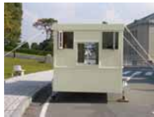
(i) 後方壁には窓を3箇所設置。上部窓は回転式で、左右方向風も室内に取り入れ可能
