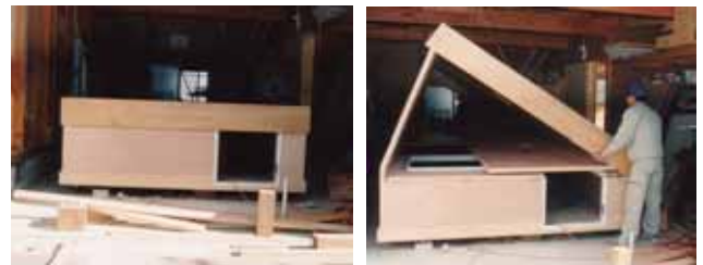
(a) 折置んだ状態：正面より撮影 上部から被さった状態の (b) 屋根の右側を持ち上げた状態 この時点で屋根の左部分も固定部分が屋根である。
