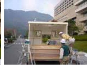
(d) 奥の壁を起こすと、側壁が固定される
