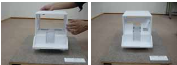
(c)天井部分を持ち上げ、側壁を垂直に起こした状態 (クレーンを静止する) (d)前面の壁を人力で、前方に垂直になるまで起こす
