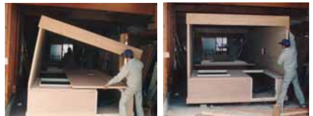
(c) 屋根の右側を持ち上げ、右側の壁を起こす (d) 左右の壁を起こした状態
