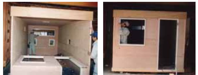
(e) 奥の壁を起こした状態 この段階で側面の壁が安定す (f) 組み立てを完了した状態を正面より撮影
