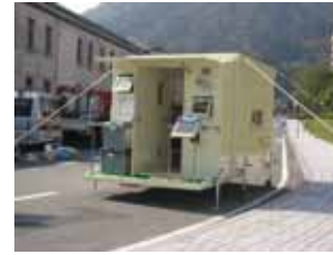
(f) 約45分で設置完了。最後に転倒防止用ロープを張る
