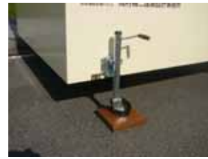
(j) ジャッキを6箇所設置。25cmまでの高低差、またベースにより軟弱地盤に設置可能
