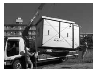
写真6 試作品3の設置作業状
