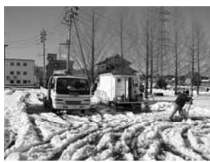
写真3 試作品2の設置状況(小千谷市)
