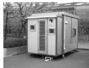
(d) 組立て後の外観
