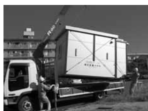
写真6 試作品3の設置作業状
